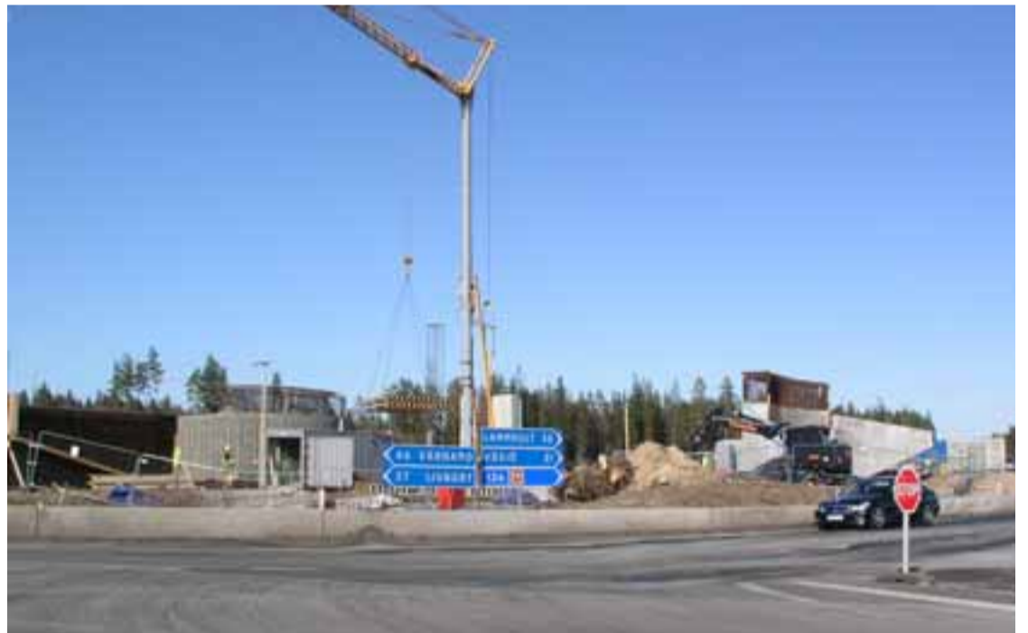
Byggnationen av den planfria korsningen vid Forsa är i full gång. Ett första steg i den plan för omläggning som Alvesta Alternativet tog fram redan 2003. Nu kan man se att detta är den naturliga lösningen på väg 126 framtida dragning. Förhoppningsvis kan detta bli en väckaklocka för övriga politiker i Alvesta.
