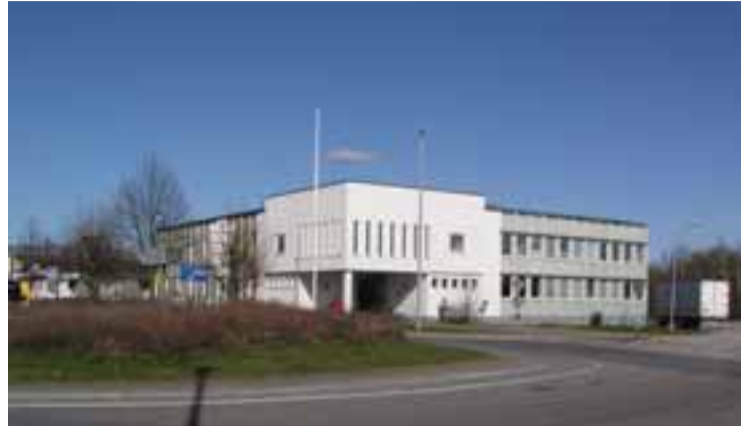
KLS gamla kontorsbyggnad fick ersätta Alvedoors i Utvecklingsbolagets jakt på lokaler för Sydarkivera och dess dokumentlager.
