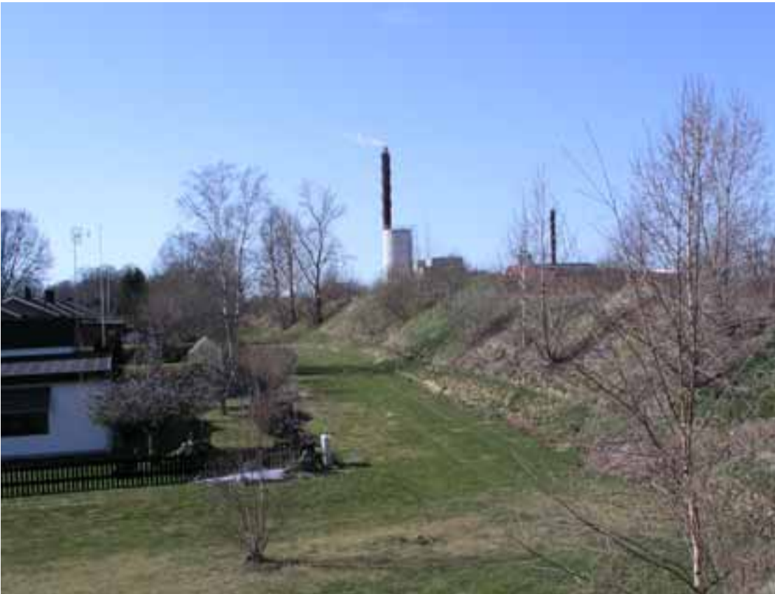
Den skyddsvall som idag ligger längs järnvägen bakom de 10 villorna på Hagavägen måste flyttas om man skall få rum med det nya mötesspåret. Hur detta skall lösas framgår inte av Trafikverkets samrådsremiss.
